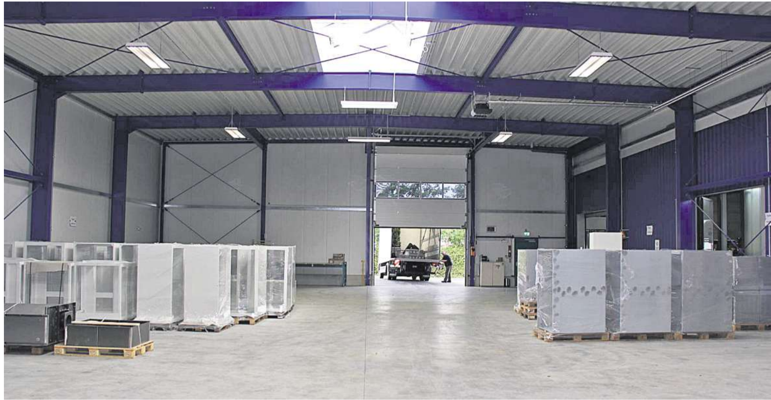
Ein Blick in die 600 Quadratmeter große Halle. Sie kann bei Bedarf zweigeschossig ausgebaut werden.
