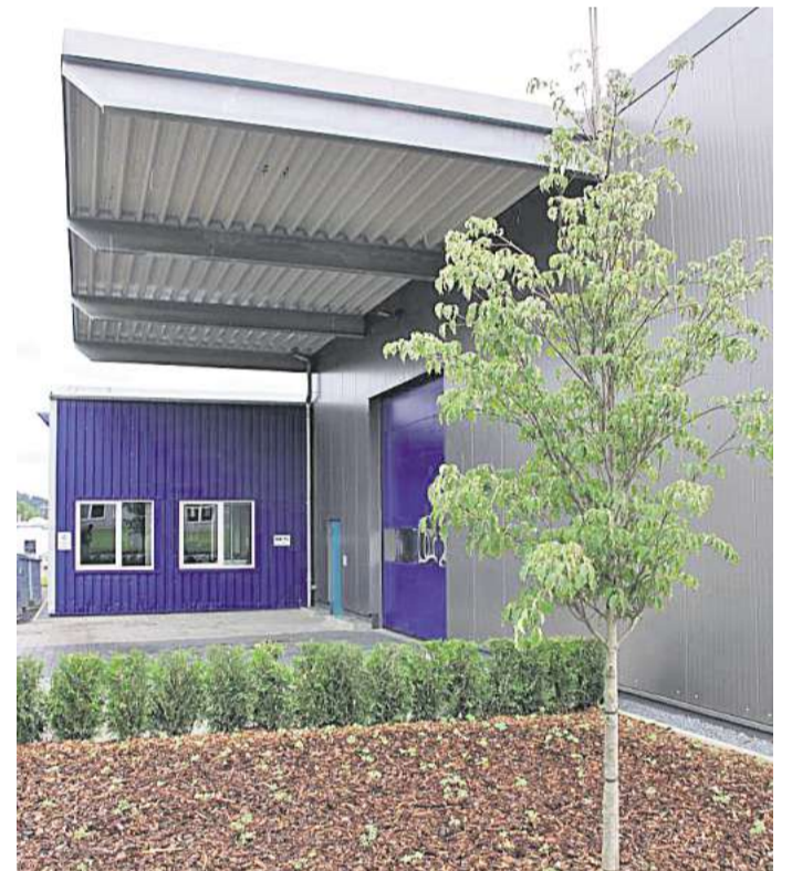
Die Transporter fahren jetzt zum Ent- und Beladen direkt in die Lagerhalle.
